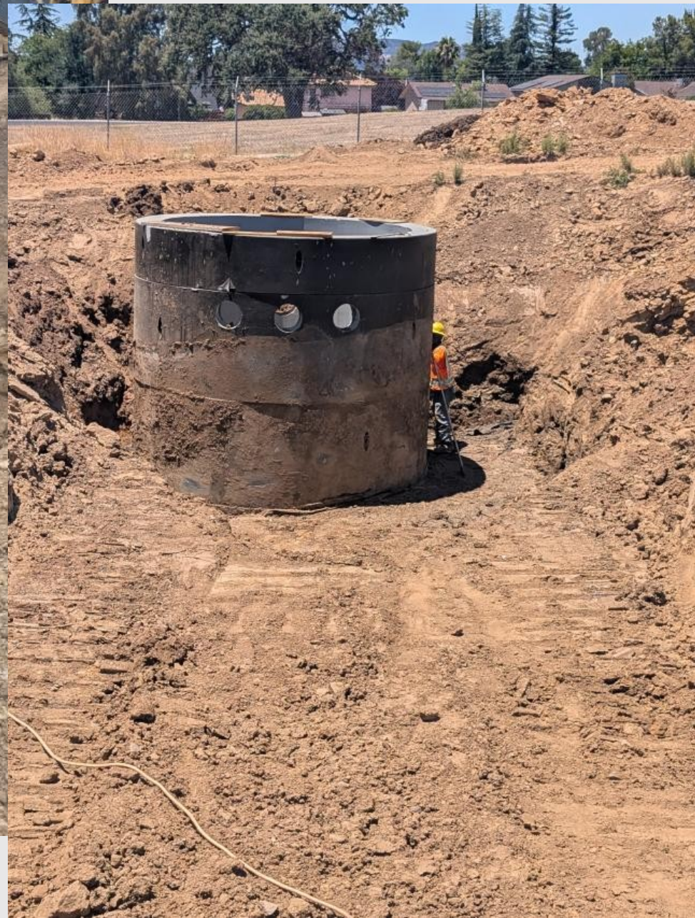
Backfill removal at ILS
