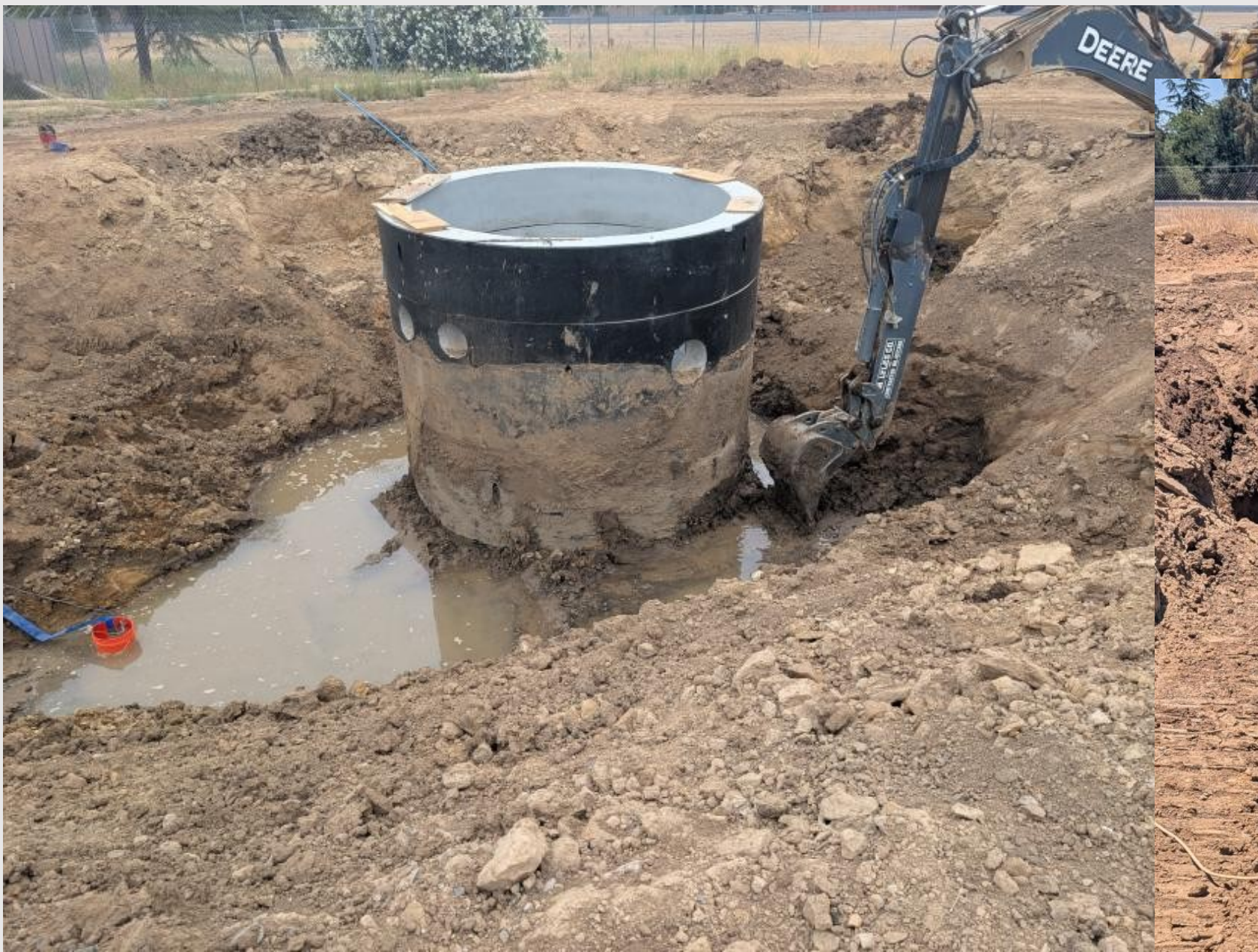
Backfill removal at ILS
