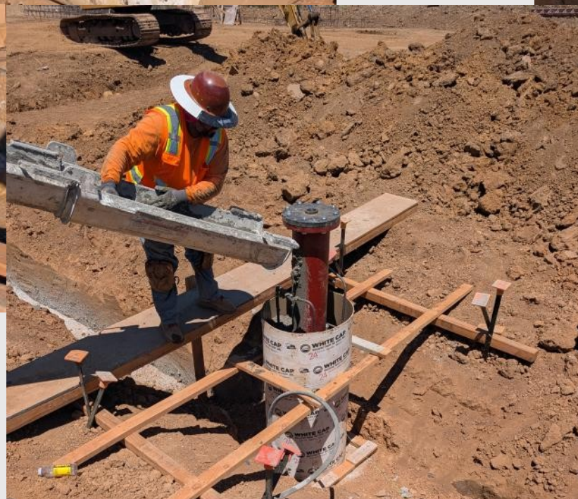
Pouring riser encasement
